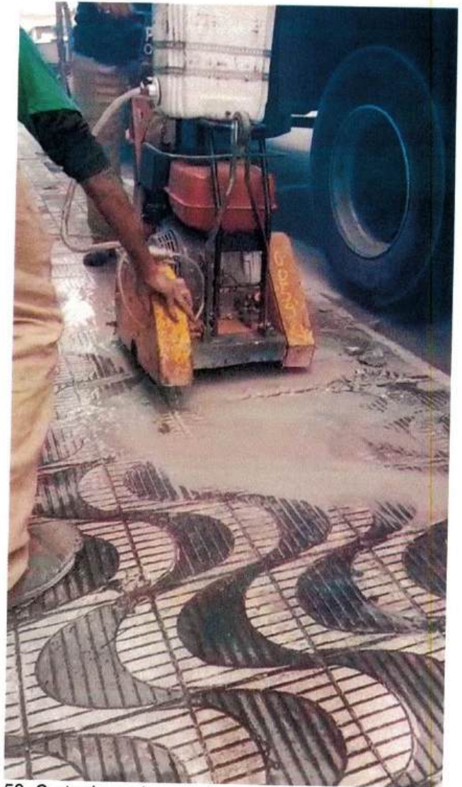
52: Corte do pavimento do passeio com Serra Clipper;
