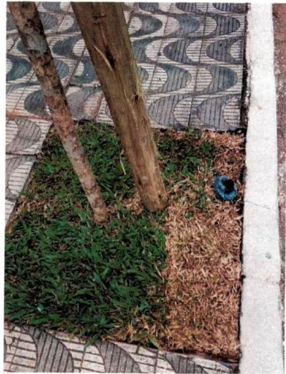
58: Visualização da forração (grama-01), do tubo dreno (02), forração cobrindo o colete (03) e tutor (04) já implantados, com plantio finalizado;
