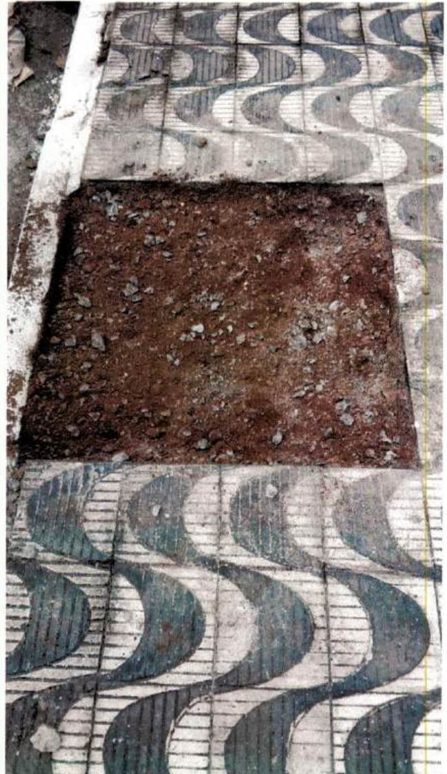
54: Abertura do colete/canteiro finalizada;
