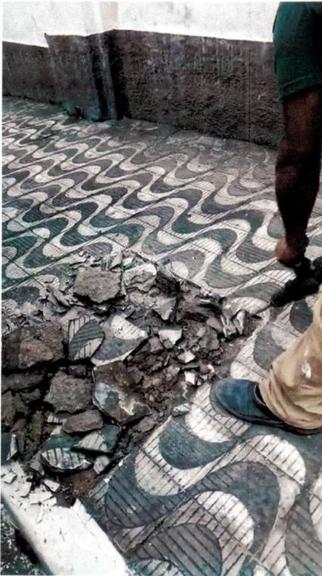
53: remoção do pavimento com Martetele de 10 kg;
