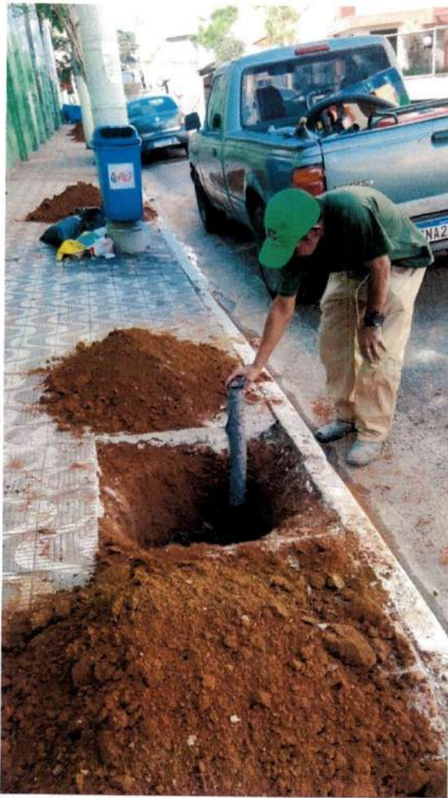
57: preparo do berço de plantio com adubação e posicionamento do tubo dreno para rega das raízes;
